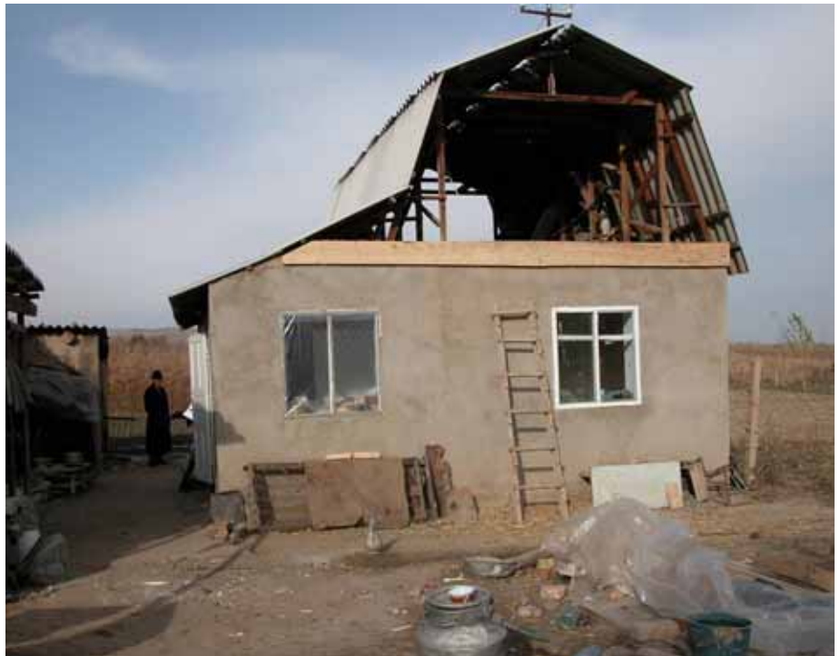
Haus in Kashka-Suu, das isoliert wurde
