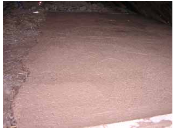
Überzug auf gedämmte Fläche
