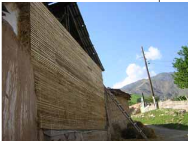
Fassade mit feinen Holzlatten
