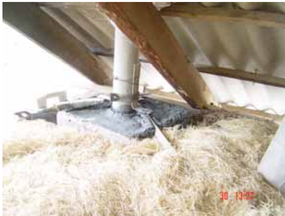
Isolation und Kaminausrollung
