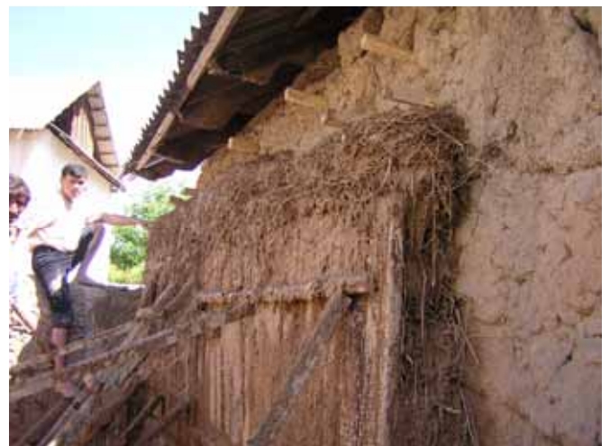
Strohlehm als Dämmung
