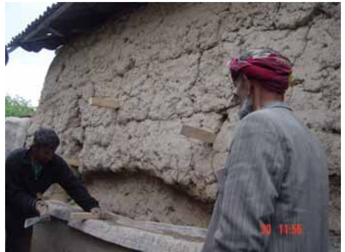
Nordfassade vor der Isolation
