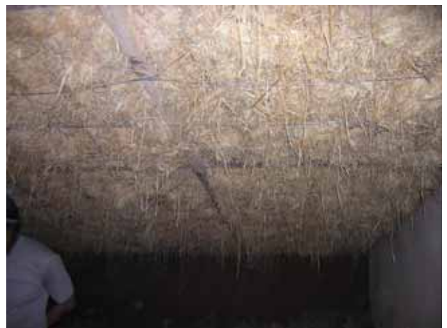
Trockene Strohdämmung an der Decke
