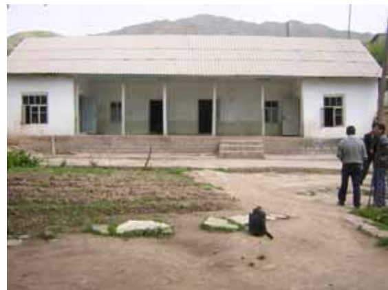
Das Objekt, wo das Zimmer ganz rechts isoliert werden soll
