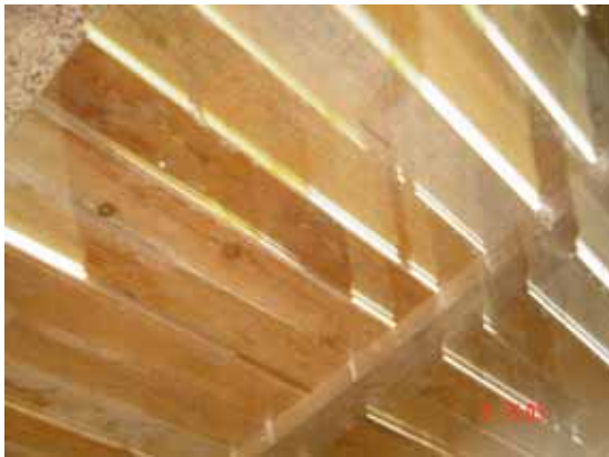
Bestehender ungedämmter Boden
