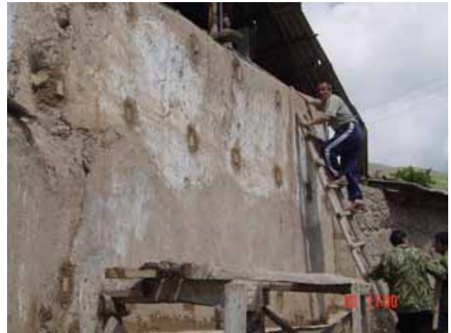
Holzdübel in Lehmwand
