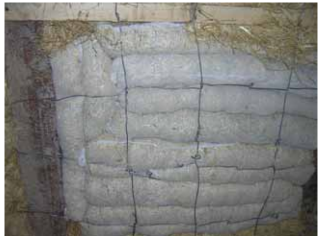
Eingesetzte Strohwürste
