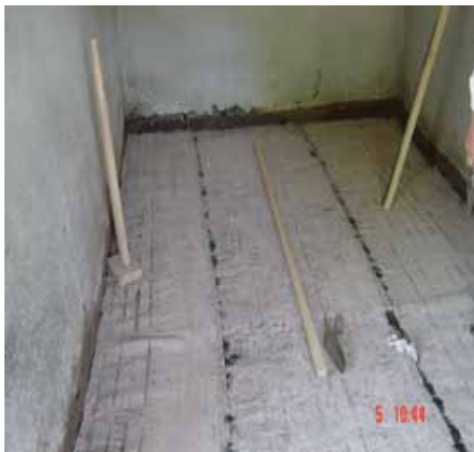
Dachpappenwanne auf Lehmboden
